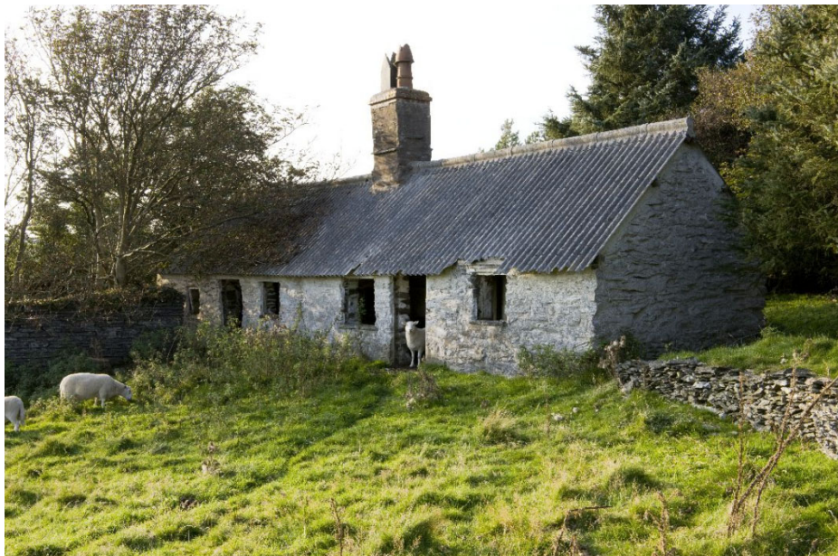
Bwlch Du -September 2008- Coflein
